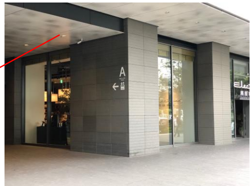
A エレベーター入口
